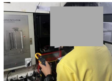
ภาพที่ 2.2-15 การตรวจเช็คระบบป้องกันและเตือนอัคคีภัย
