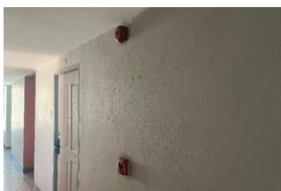
Alarm Bell และ Fire Alarm Manual Station
