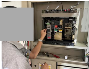
ภาพที่ 2.2-13 การตรวจสอบระบบ MDB และ Generator
